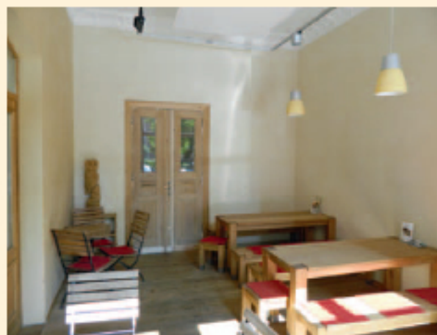
Café mit lehmverputzten Wänden
